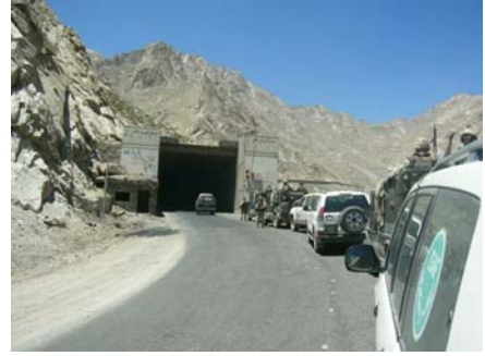
A Szalang-alagút bejárata
