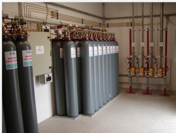
Automata gázzal oltó központ
