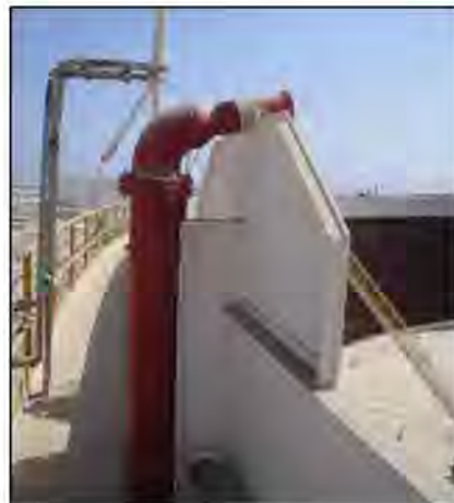
27. fénykép: Rögzített „hablövellő” ágyú beépítve [108]
