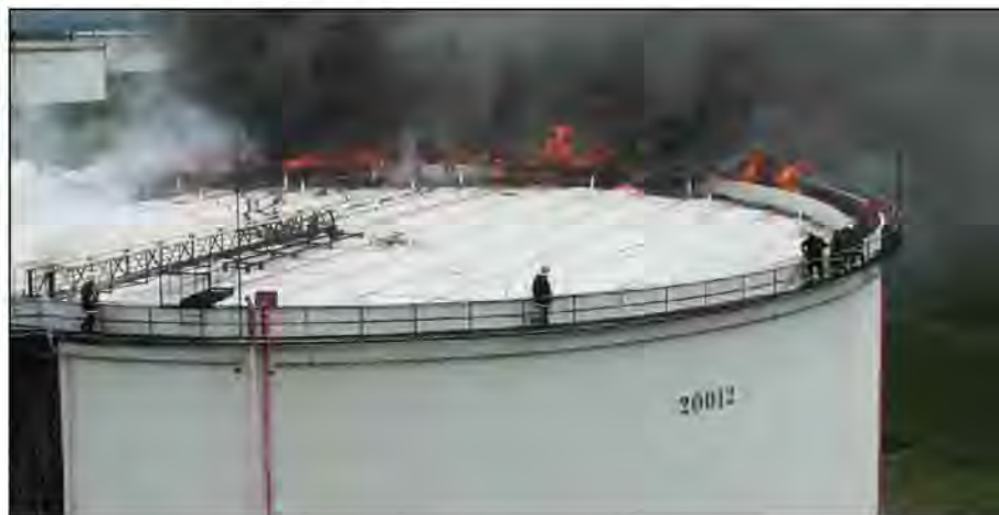
25. fénykép: Tömítőréstűz oltási kísérlet; Forrás: FER tűzoltóság 2015.
