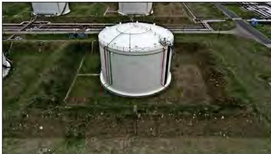
1. fénykép: Földsánccal határolt védőgödör; készítette a szerző 2009.
